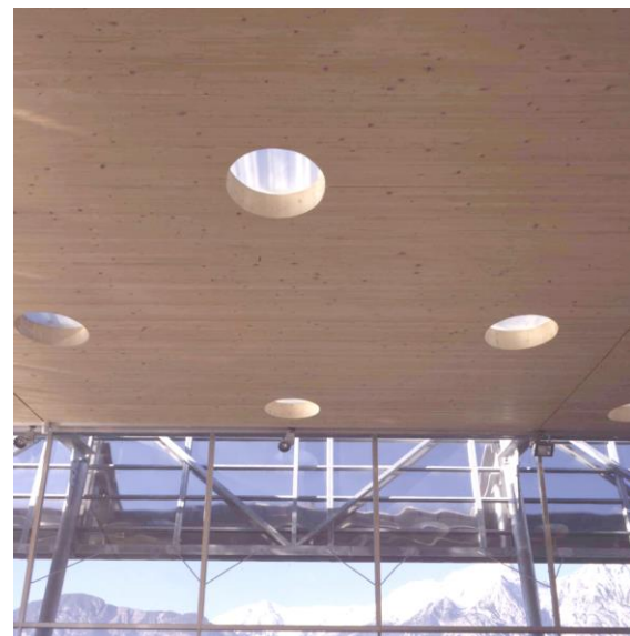
Fiat Oberhofer, Mils Foto: Paul Ott Gewölbte Brettstapeldecke zwischen HEB-Profilen
